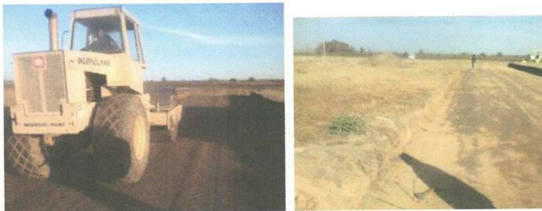
Figura 24:: Proceso de compactación de la sub base y base terminada
