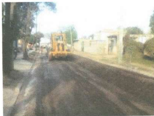
Figura 8: Preparación de base granular
